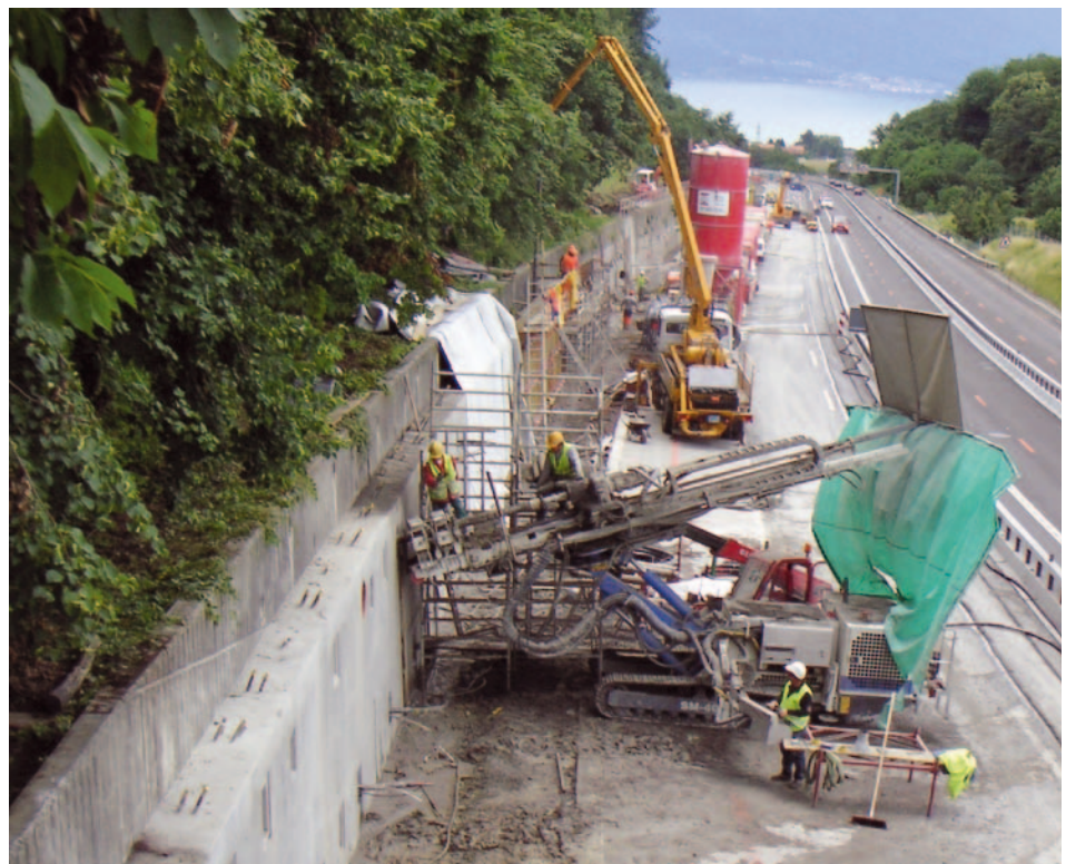
Foreuse SM 401 et installations de chantier
