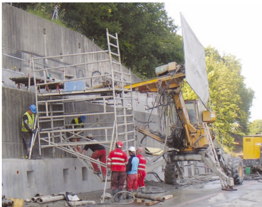
Forage en hauteur à l'aide d'une foreuse Menzi et d'un échafaudage
