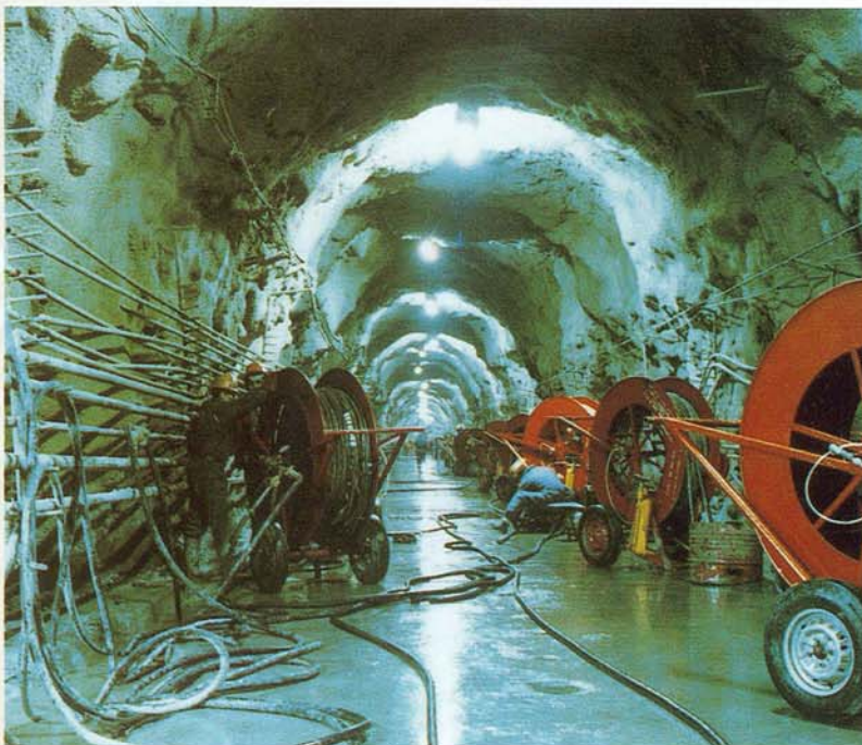
Vue de la galerie GP1
