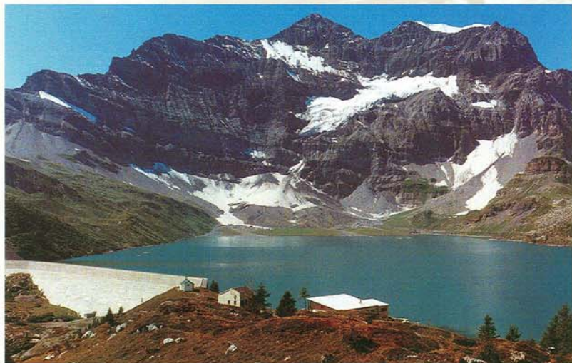
Site du barrage de Salanfe
