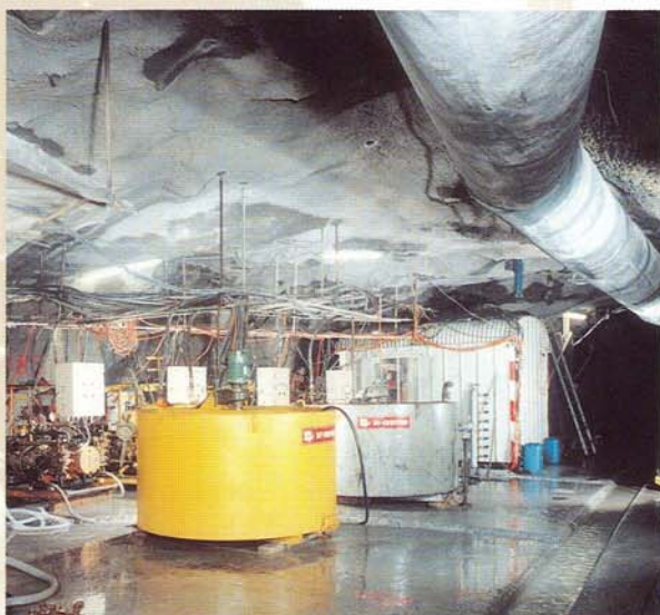
Centrale d'injection en galerie gérée par EPICEA
