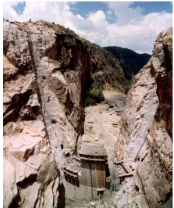
La gorge après excavation
