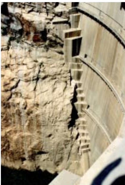
Vue de l'appui rive droite vers l'aval
