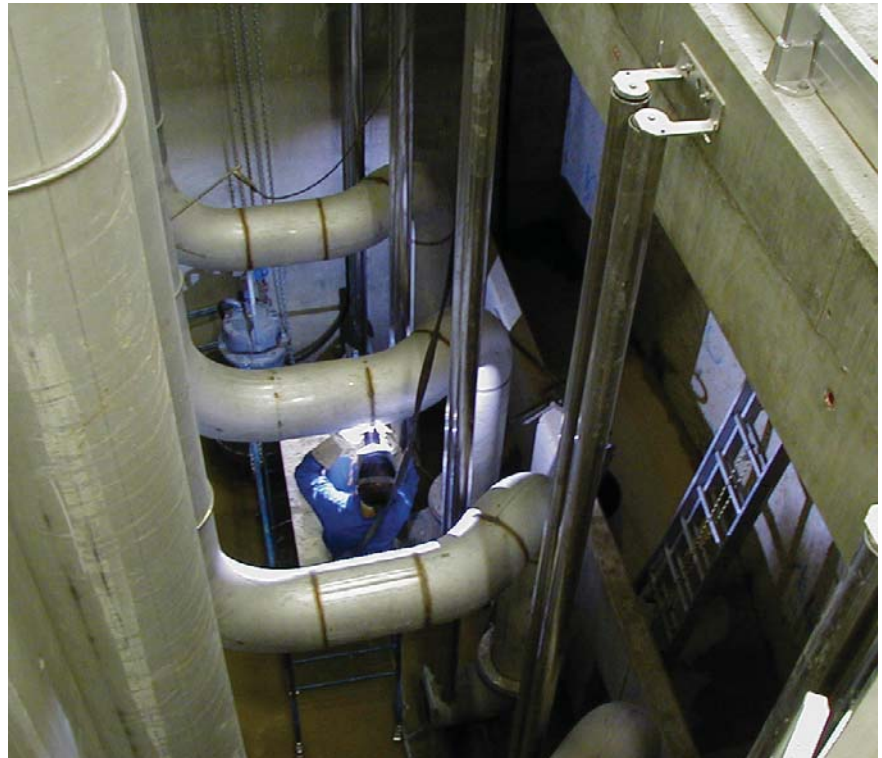
Assemblage des conduites de relevage du poste de pompage
