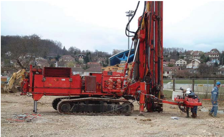
Réalisation des micropieux d'ancrage
