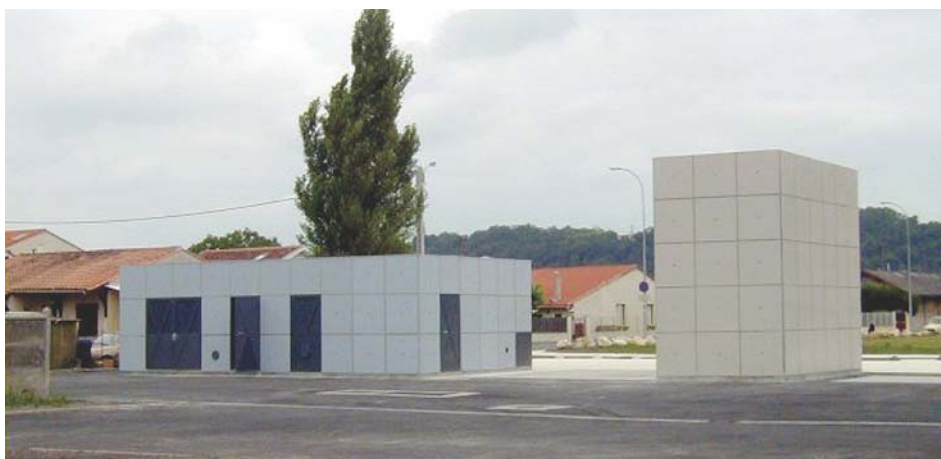
Vue de l'ouvrage après travaux
