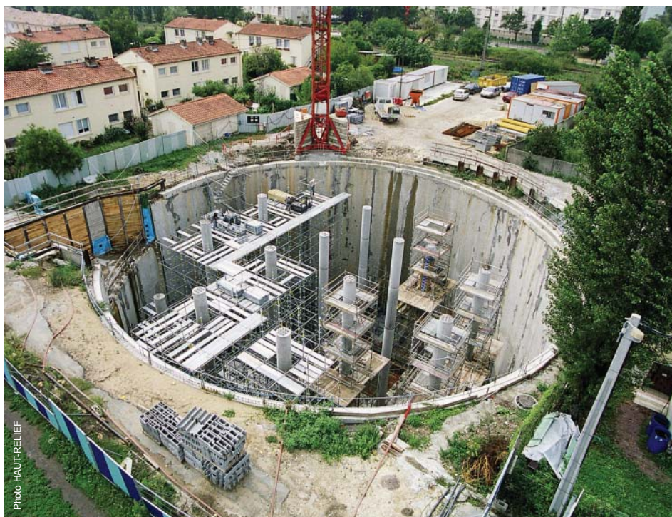
Fin de la construction des poteaux, préparation de la dalle de couverture
