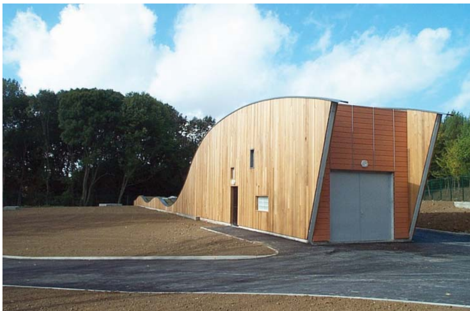
Vue sur le local technique en surface, intégré dans un parc paysager
