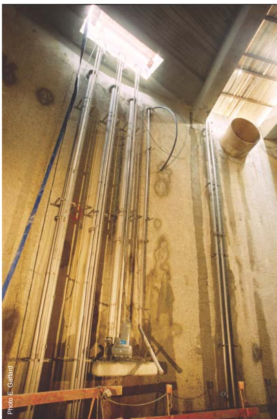
Relèvement du bassin
