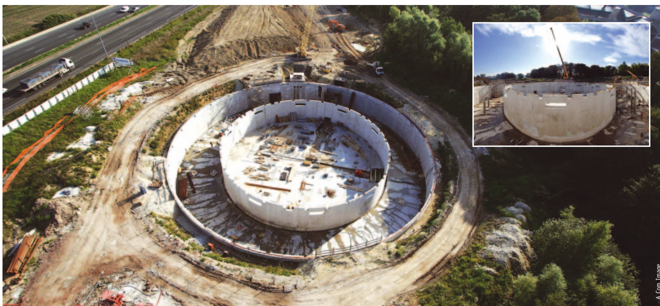
Vue aérienne pendant les travaux
