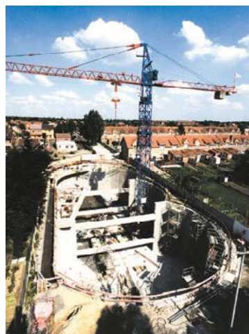
LIEVIN - BASSIN DUSSUICH Vue générale
