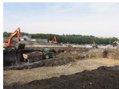
Extraction des matériaux hors nappe
