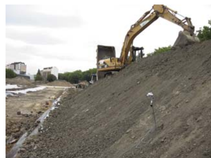
Contrôle du traitement biologique des terres polluées par des hydrocarbures
