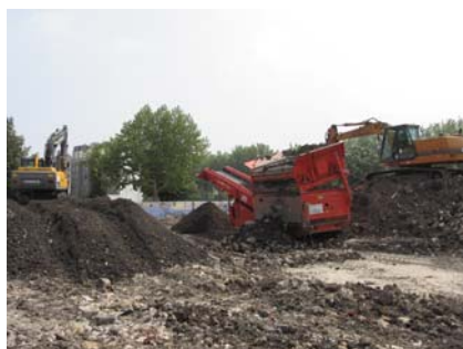
Traitement des matériaux dans une alvéole étanche
