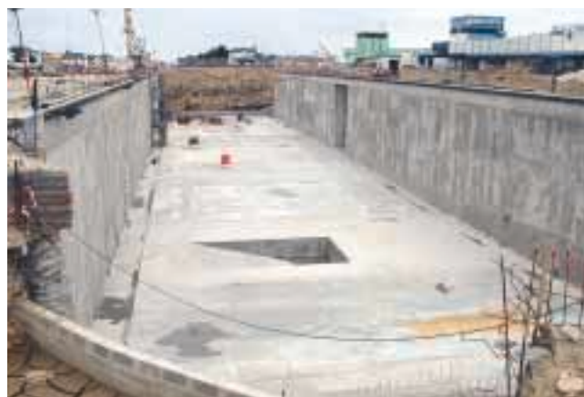
Vue de la cale après coulage du radier béton armé
