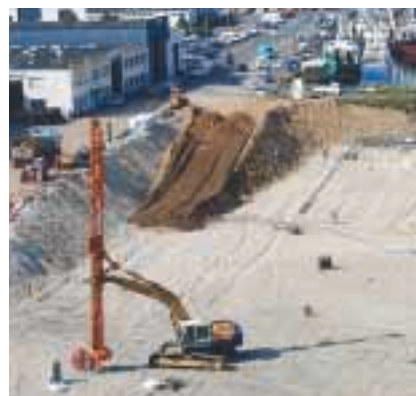
Fonçage des drains plats
