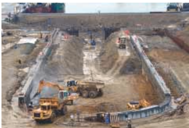
Poutre de couronnement et rabotage des bajoyers
