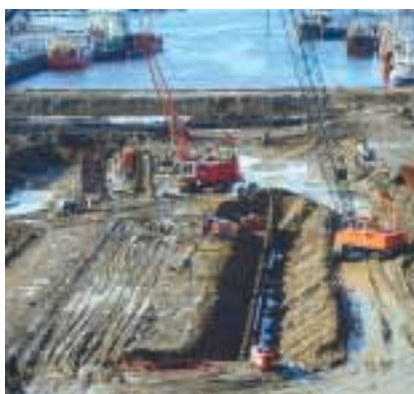
Paroi moulée et battage des palplanches
