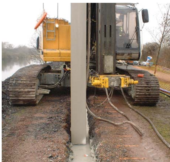
Réalisation de la paroi mince au coulis
