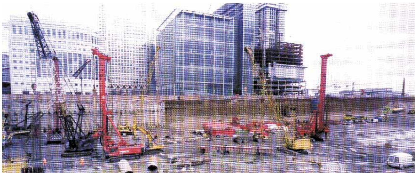
Travaux en cours
