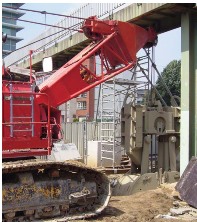
Réalisation de la paroi sous hauteur limitée
