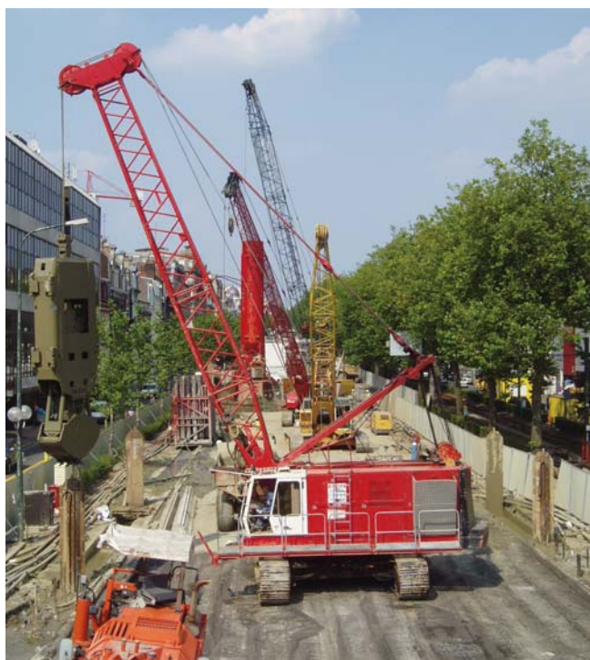
Réalisation de la paroi moulée
