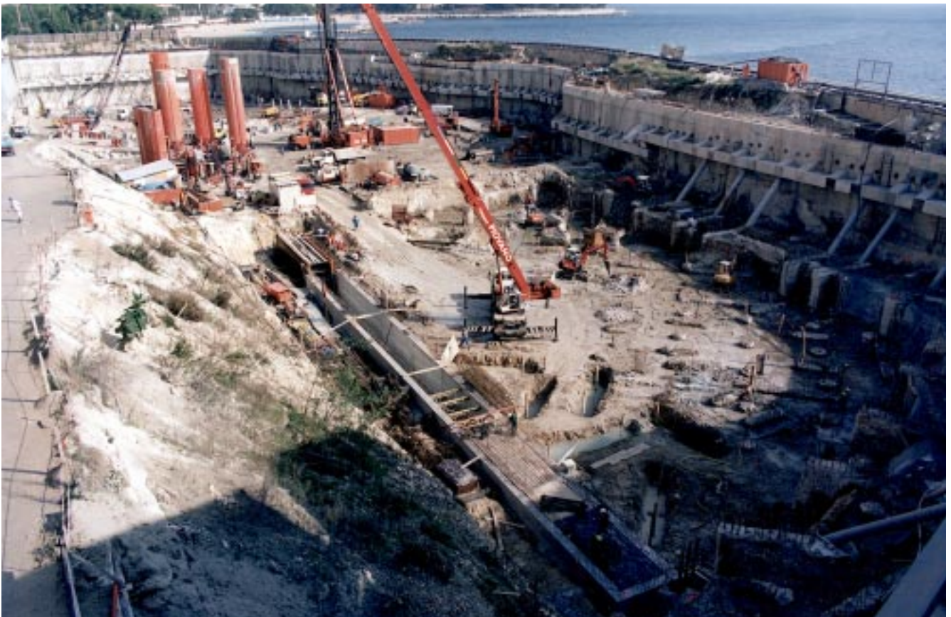
Vue en plan de la zone sud (galerie drainage, fondations dégagées, butons installés)
