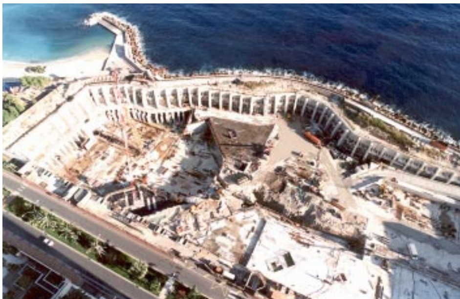
Vue générale du chantier (parois moulées avec contreforts, parois en T, radiers)
