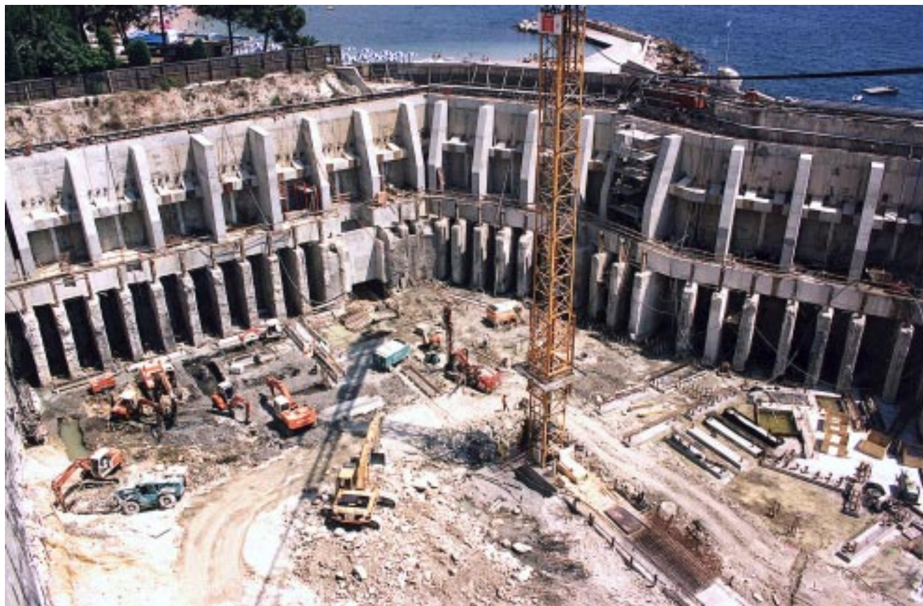
Vue de la zone nord et du confortement (nervure des parois en T, dalle transfert, contreforts)
