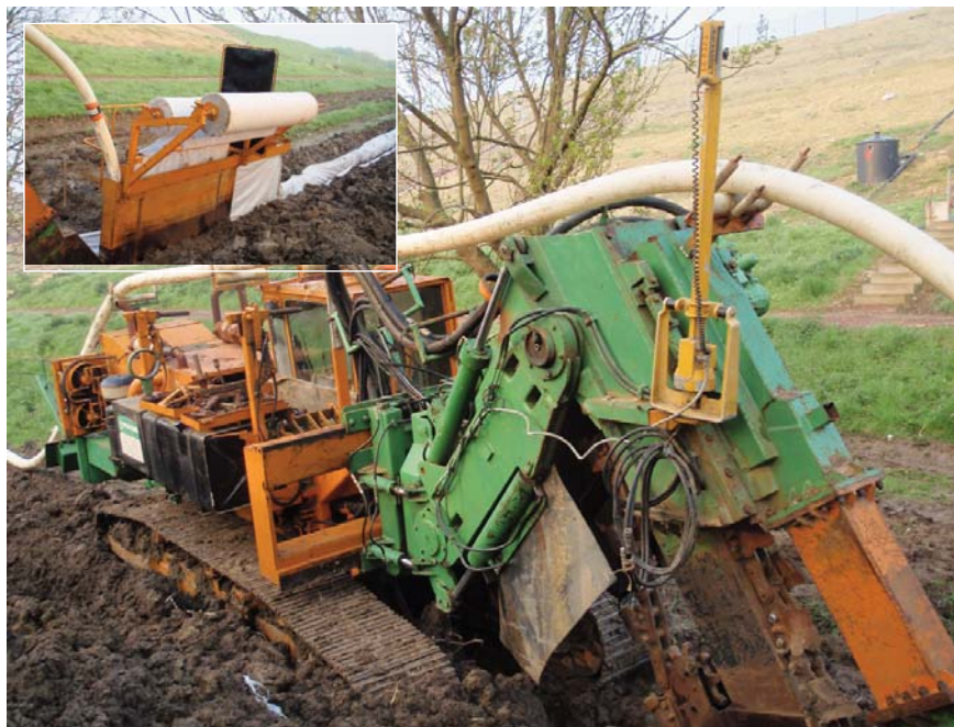
Réalisation de la tranchée drainante
