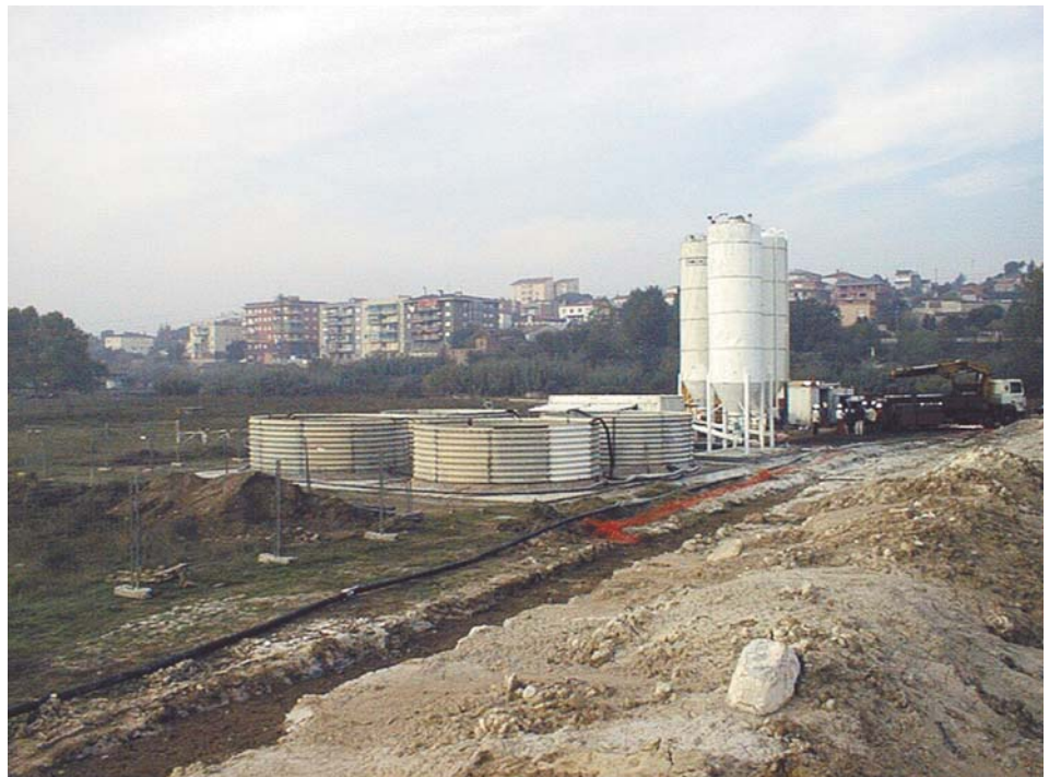
Vue générale du site en cours de travaux
