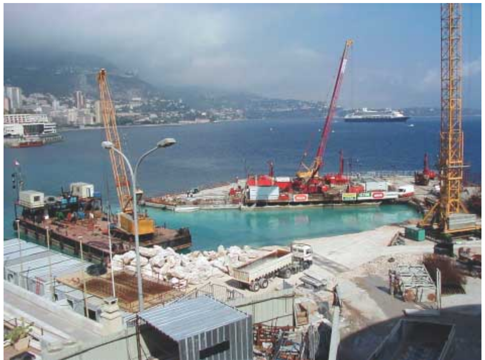
Vue générale du chantier
