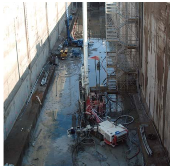
Jet grouting sous le radier
