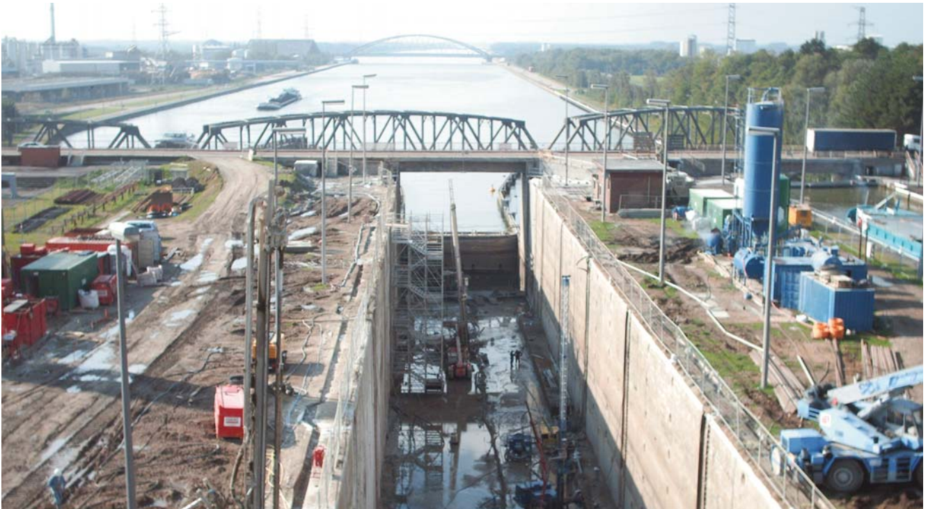
Ecluse centrale : travaux de stabilisation
