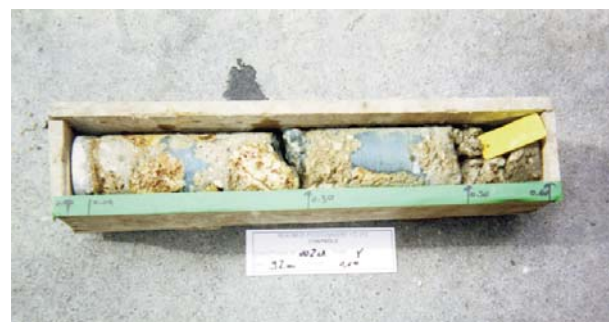
Carottage de contrôle. Les zones grises sont les zones poreuses comblées par l'injection.
