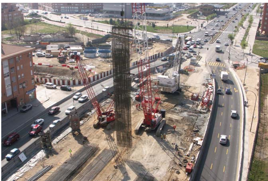
Manutention d'une cage d'armature
