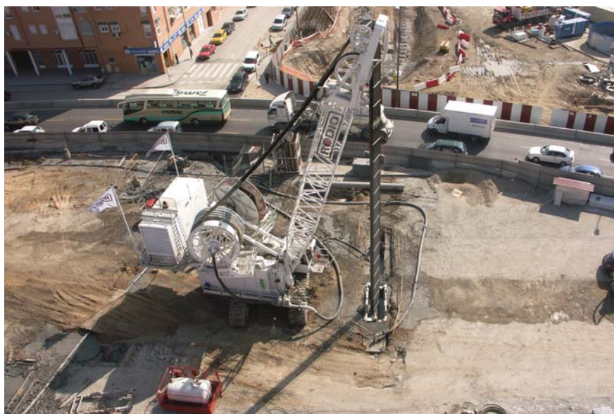
Hydrofraise en cours d'excavation
