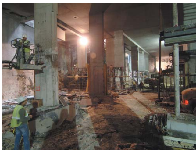
Fond de fouille terrassé à la cote 5,20 NGM, sciage périmétral et voile en béton projeté, chemisage en béton armé des poteaux en descendant au fur et à mesure des terrassements
