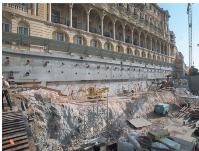
Confortement par ancrages sous l'Hôtel et réalisation de la première passe de béton du mur de soutènement
