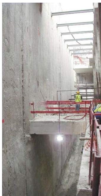
Fond de fouille à 32 m de profondeur sous 27 m de charge d'eau
