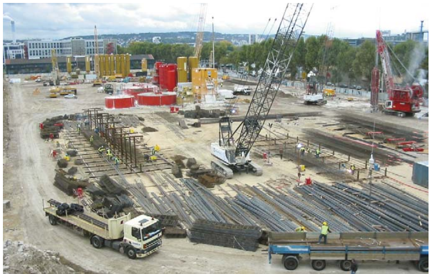
Vue générale du chantier
