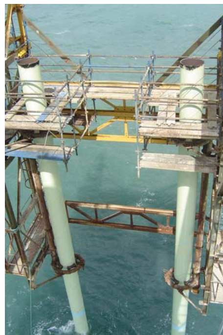
Guide de battage pour un couple de pieux
