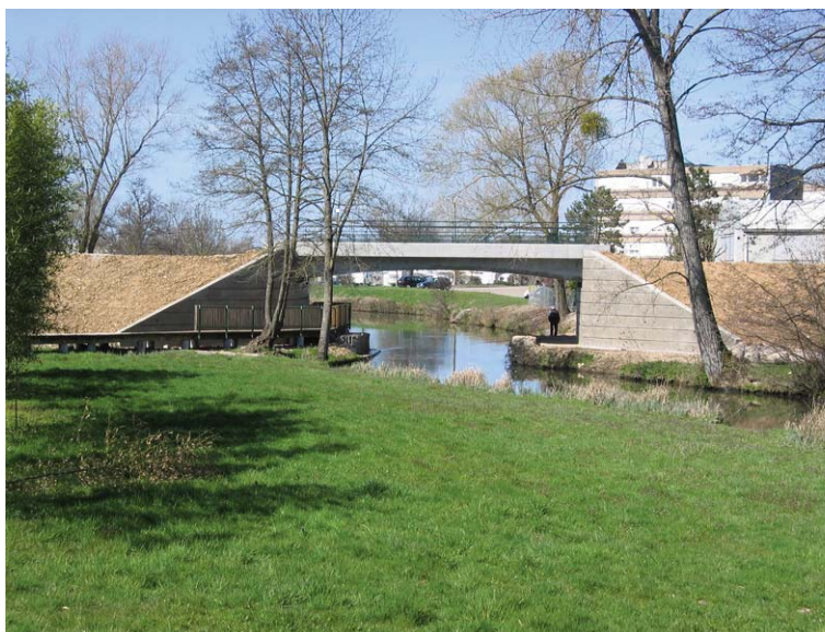
Nouveau pont de Reyssouze
