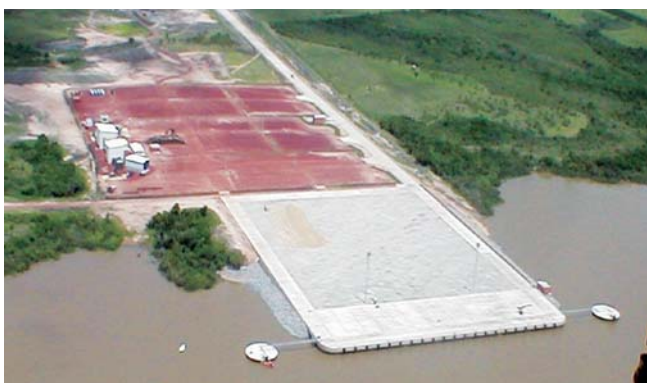
Vue générale du terminal logistique
