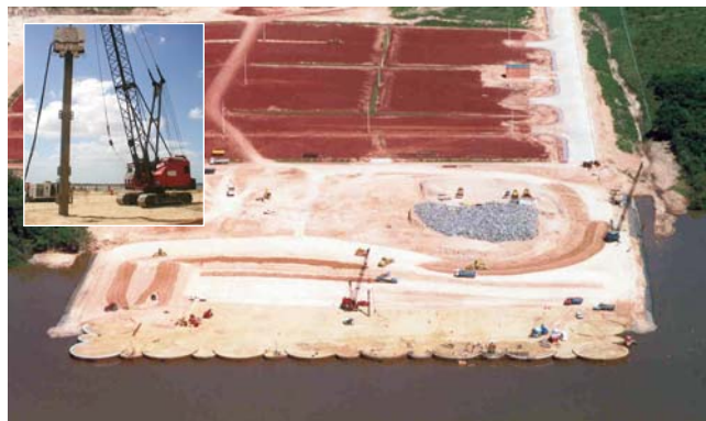
Densification du remblai par vibrocompactage
