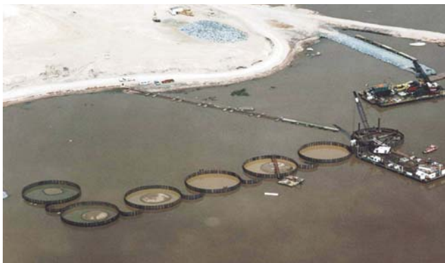
Exécution du caisson n°8 et du batardeau ouest
