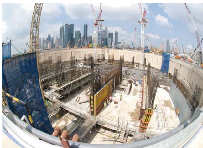
Vue des travaux dans la zone de la Tour 1
