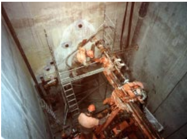
Réalisation des forages horizontaux
