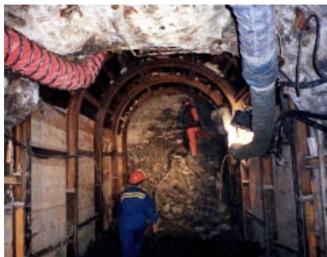
Galerie d'accès en cours d'excavation
