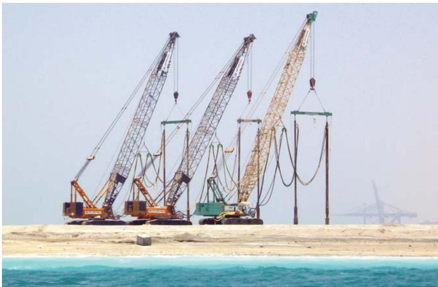
Atelier de vibro compaction tandem en action. Profondeur de traitement de 15 m
