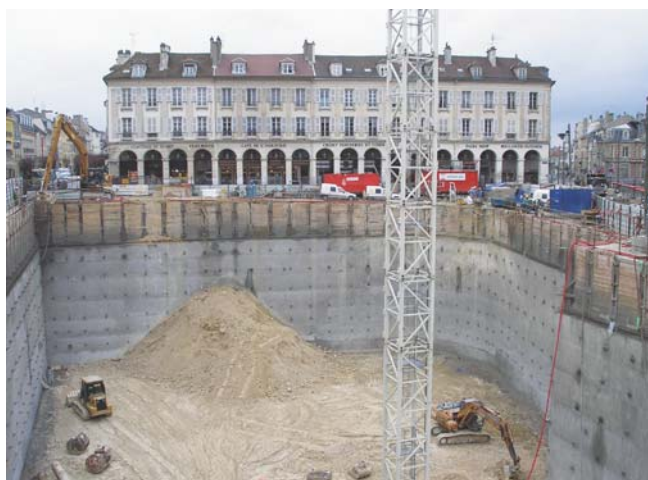
Vue du fond de fouille côté Arcades
