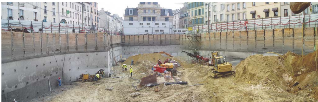
Terrassement et réalisation des clous et du béton projeté
