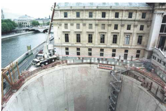
Vue de la paroi moulée circulaire terminée
