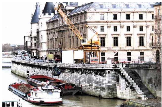
Evacuation des déblais directement par barges
