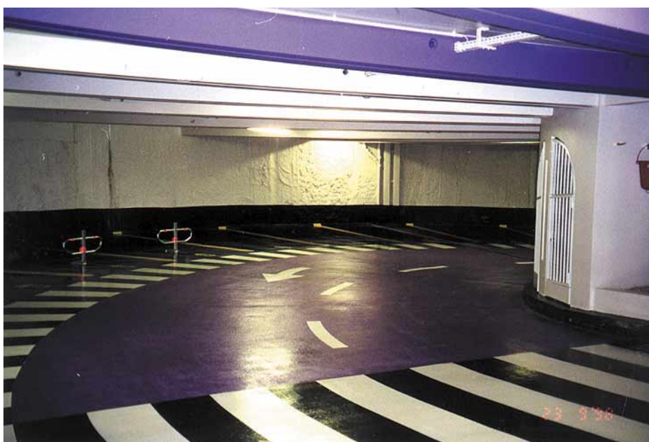
Vue du parking
