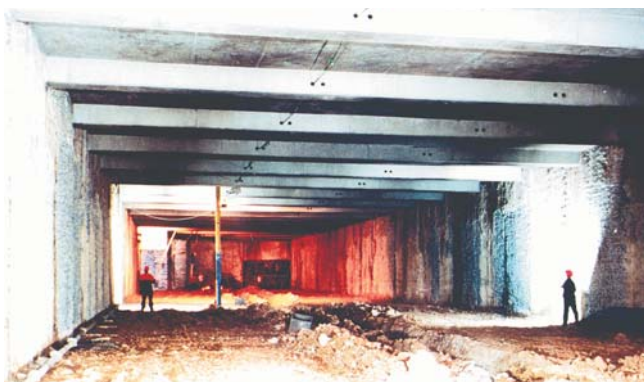
Exécution des travaux en taube sous voie publique (axe rouge)
