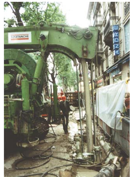
Réalisation de la paroi à l'hydrofraise "latine"
