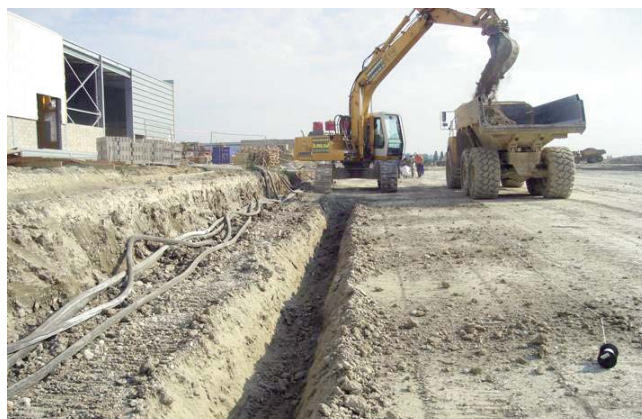
Réalisation de la pré-tranchée
