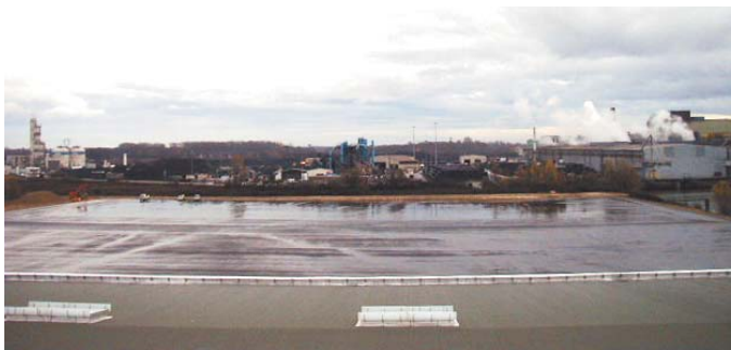
Vue de la plateforme terminée
