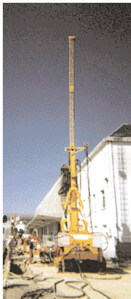
Atelier de jet grouting
