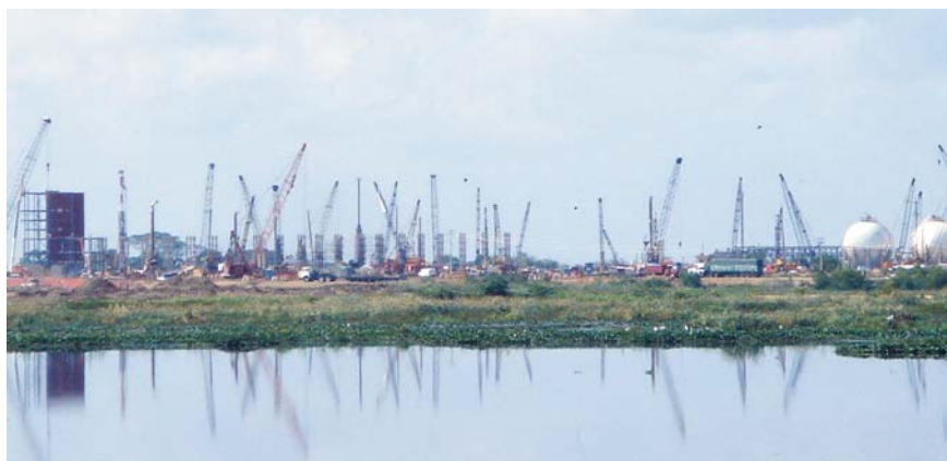
Vue d'ensemble du chantier avec sa forêt de grues
