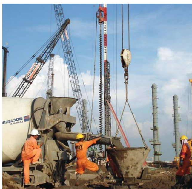
Bétonnage d'un pieu
