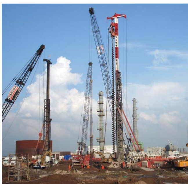
Outillage Starsol 12000 et outillage de compactage dynamique
