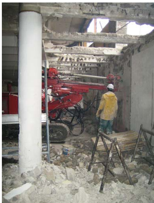
< Réalisation des tirants d'ancrage dans le sous-sol existant
