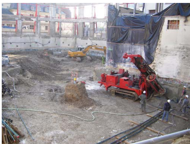
Les tirants ont été mis en œuvre au fur et à mesure du terrassement
