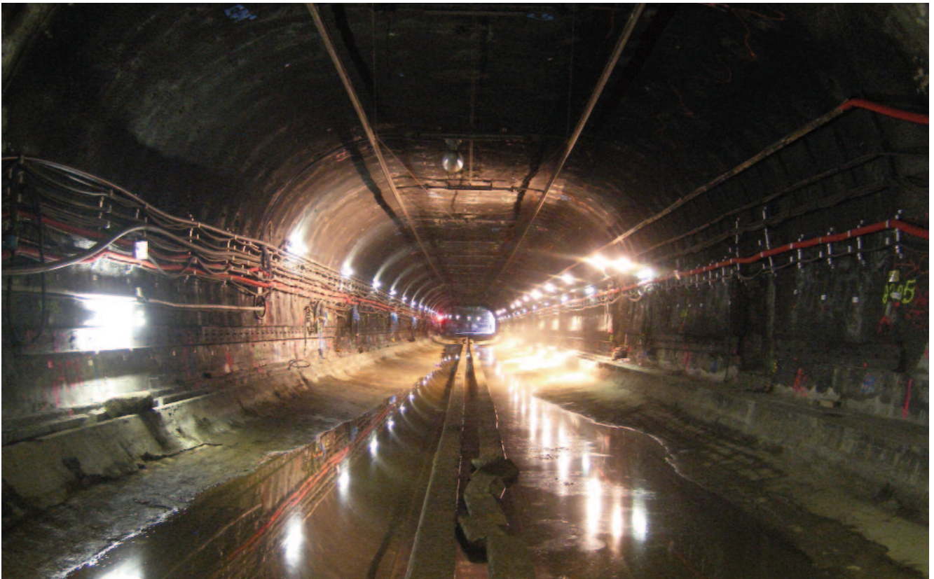
Vue du tunnel ferroviaire à 2 voies après enlèvement du ballast et des rails
