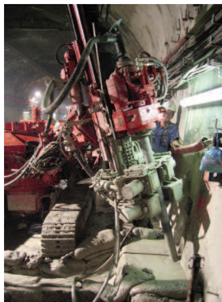
Réalisation d'une colonne de jet sous un piédroit
