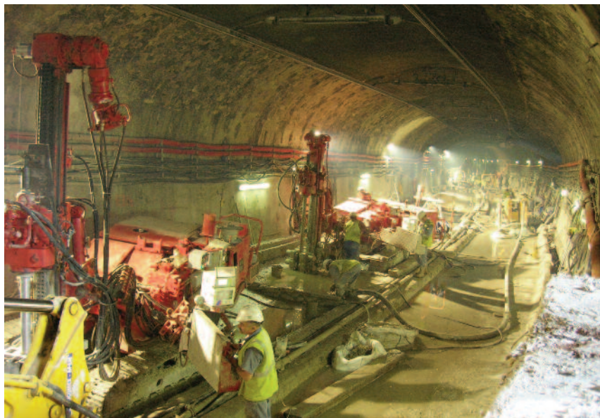
Vue du tunnel avec les foreuses de jet grouting en action
