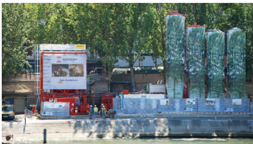
Installation sur > le quai de Seine (chantier fluvial)
