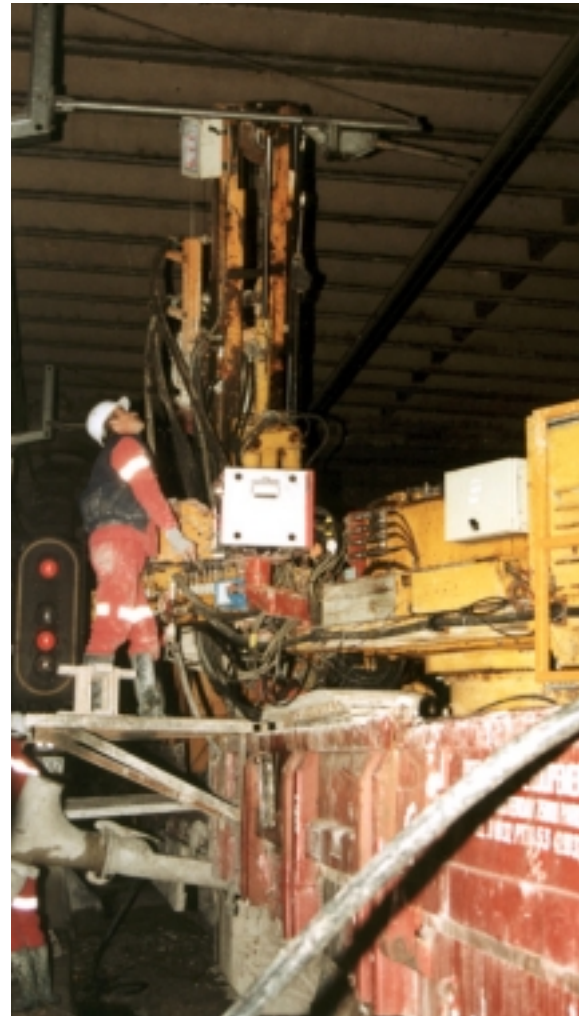
Réalisation des colonnes en emprise tunnel depuis un train travaux
