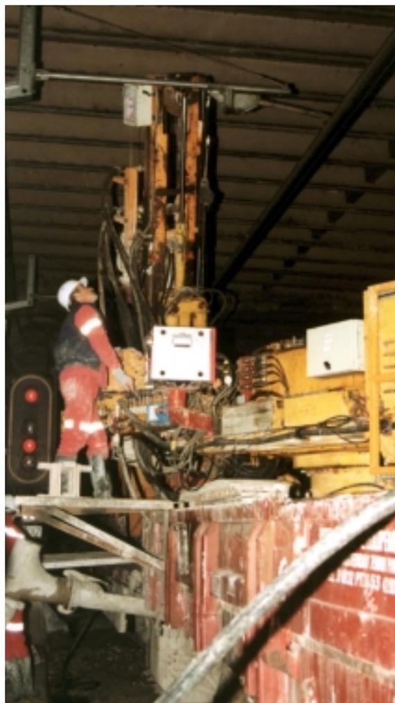
Réalisation des colonnes en emprise tunnel depuis un train travaux
