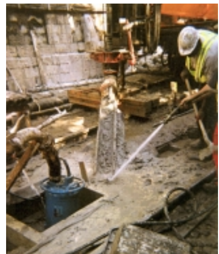
Colonne de jet double en cours d'exécution
