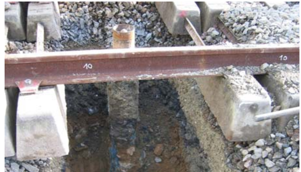
Colonne excavée sous les voies
