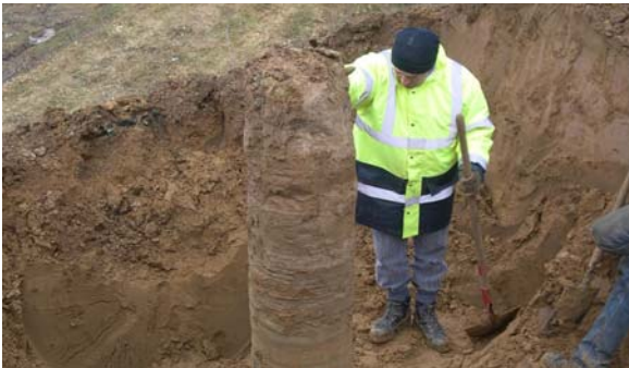
Colonne excavée à proximité des voies
