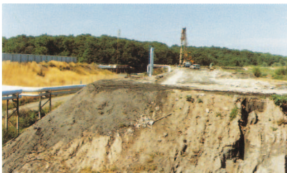
Paroi moulée en cours d'exécution depuis la digue périmétrale
