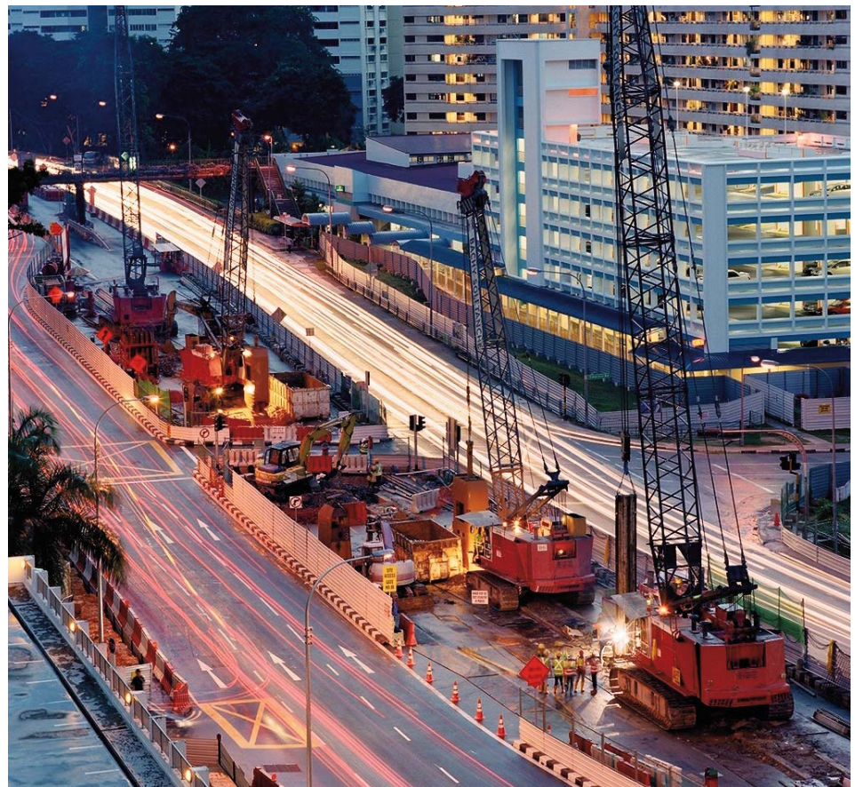
Excavation de la paroi moulée dans un «îlot» au milieu de la chaussée
