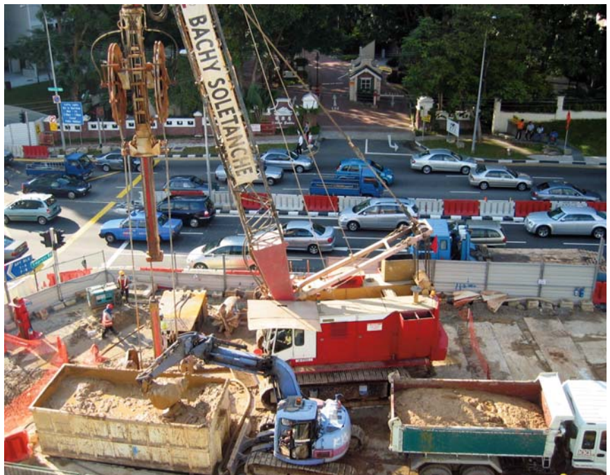
Atelier d'excavation KS3000
