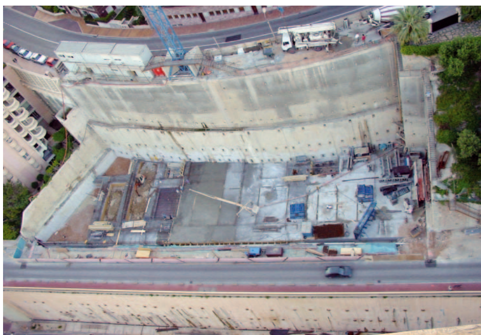
Soutènement et contreforts avant exécution de la dalle de transition
