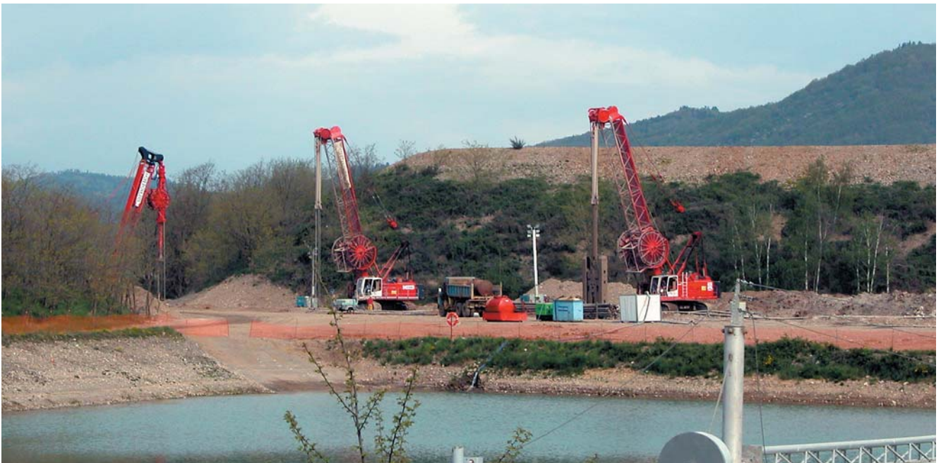
Vue d'ensemble du chantier
