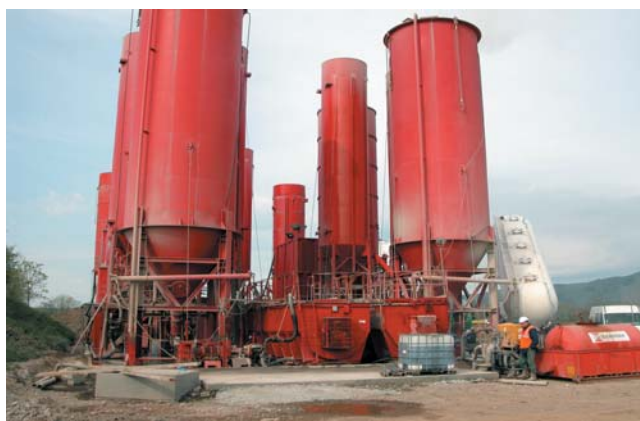
Vue de l'unité de production de coulis (50 m 3 /h)
