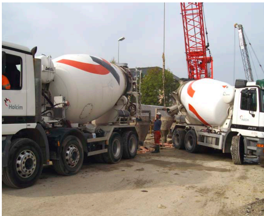
Bétonnage en cours
