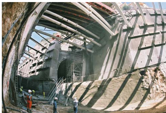
Tête amont, intersection entre la galerie technique et le tunnel T 33
