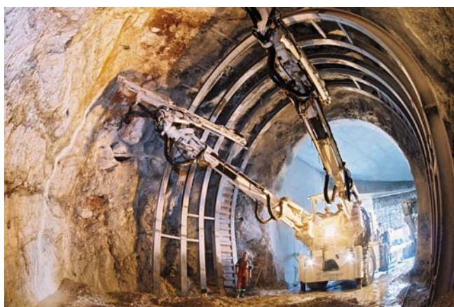
Le Robofore utilisé pour le creusement depuis la tête aval
