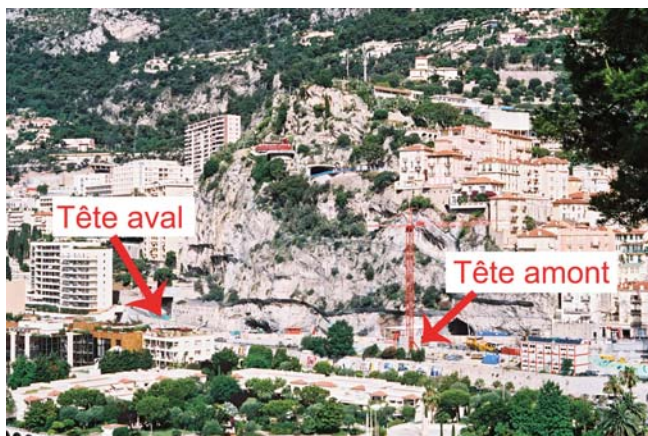
Le chantier dans son environnement
