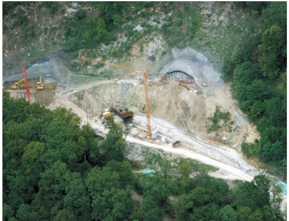
Vue aérienne du chantier
