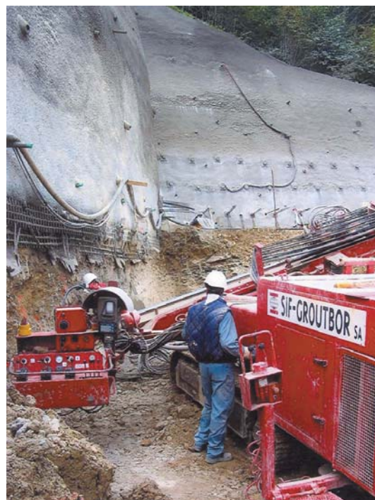
Exécution du forage (foreuse CASAGRANDE C6)
