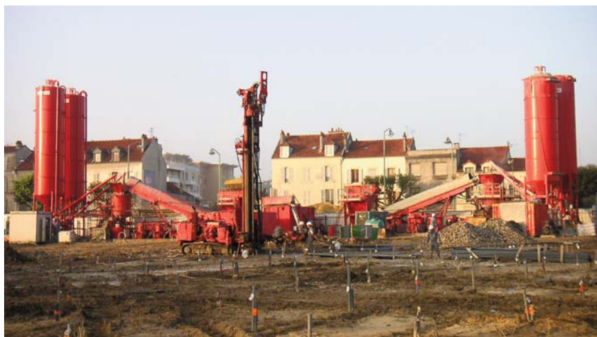
Centrale de fabrication du mortier
