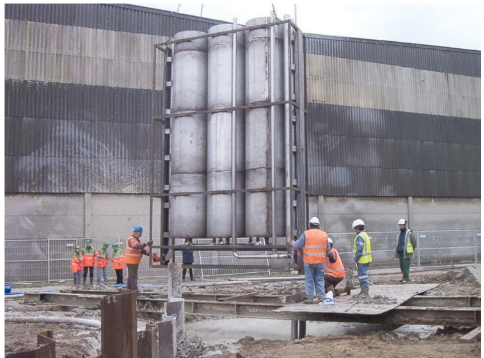
Pose de la porte filtrante
