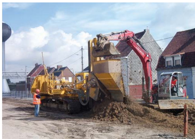
Réalisation des drains
