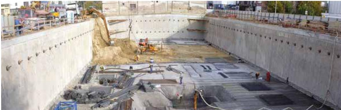
POLONIA - Varsovia - Prosta Center - 3.600 m<sup>2</sup> de muro pantalla de 0,60 m de espesor
