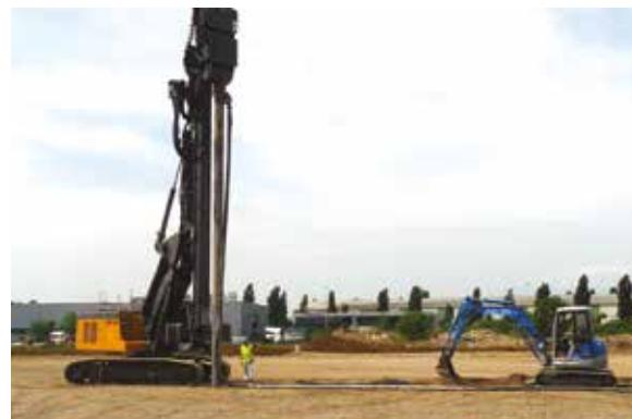
Realización de inclusiones rígidas con tubo vibro-hincado
