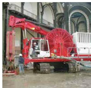
Magnitud de desviación: sin precauciones específicas, la desviación de la herramienta de perforación es del orden del 1% de la altura excavada. En ciertos casos puede reducirse hasta el 0,3% tomando determinadas precauciones específicas tales como:
