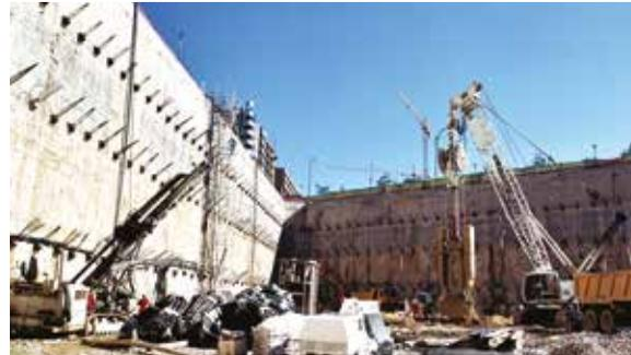
ESPAÑA - Valencia - Corte Inglés - Muro pantalla de 54 m de profundidad
