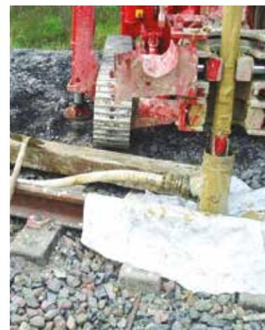
Introducción de la herramienta perforadora en el ante-pozo entubado
