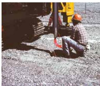
Instalación de la zapata de anclaje del dren en el suelo
