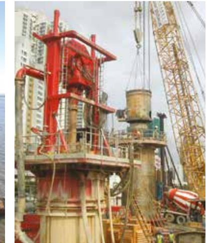
HONG KONG - 402 Máquina de perforación de pilotes con circulación inversa
