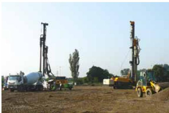
A gauche, la machine d'inclusions et à droite, la machine de colonnes ballastées
