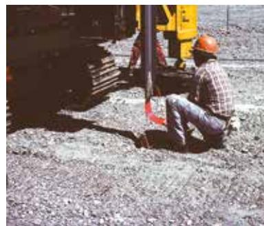
Installation du sabot d'ancrage du drain dans le sol
