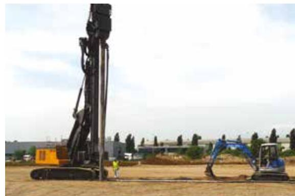
Réalisation d'inclusions rigides avec tube vibrofoncé
